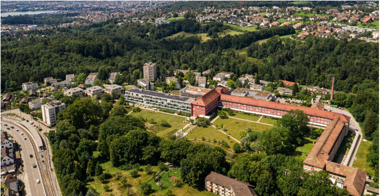
Areal Diakoniewerk Neumünster: Baumbestand
